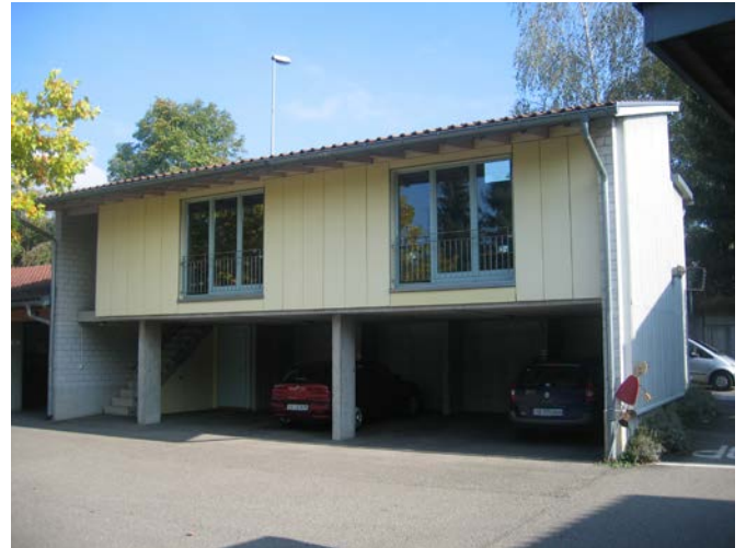
Atelier und Unterstand bebauungsseitig.
