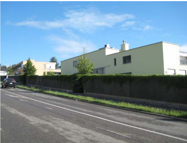
Mauerkrone im Gefälle parallel zum Strassenverlauf.
