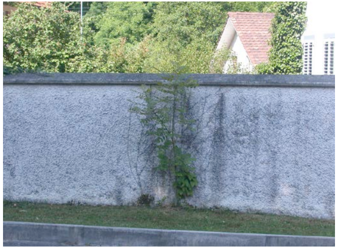
Verputzte Mauer mit Abdeckplatte.
