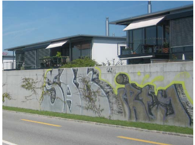
Sprayschutz bei glatten und einfarbigen Oberflächen ermöglicht eine einfache Entfernung.
