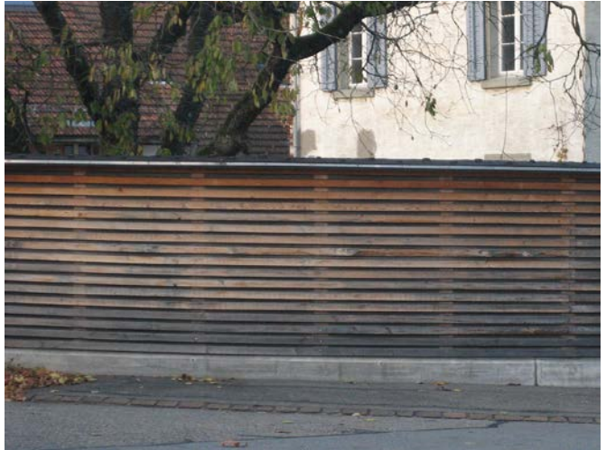
Holzwall mit horizontaler Lattung.
