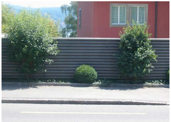
Betonelemente mit absorbierender Wirkung und horizontalen Rippen.
