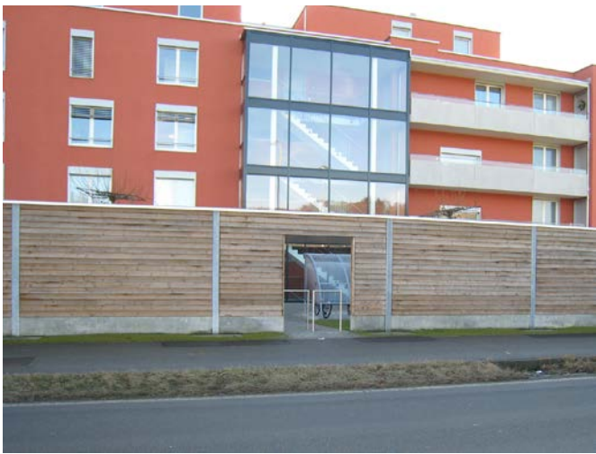
Sichtbare Tragkonstruktion bei einer Holzwand.
