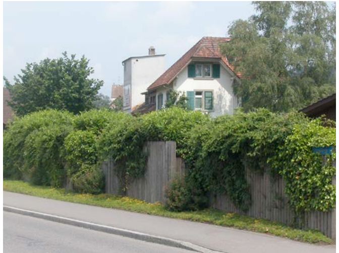
Kletterpflanzen über einer Lärmschutzwand bei genügend grossem Vorbereich.
