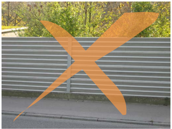
Unbefriedigende Einordnung: Sichtbare Tragkonstruktion mit Stahlpanels.
