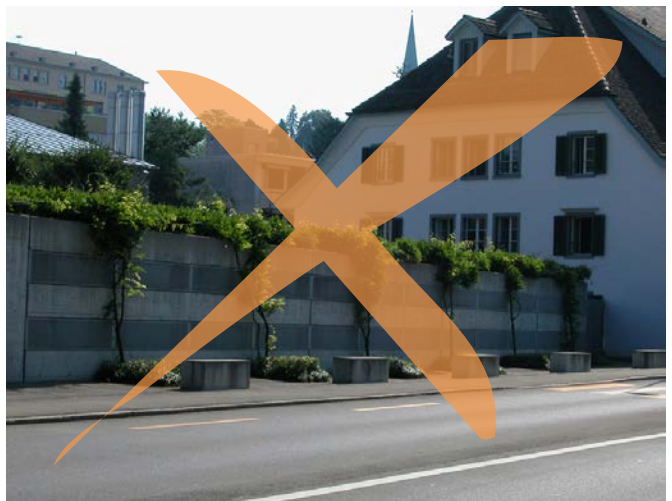
Unbefriedigende Einordnung: Strassenseitige Kletterpflanzen mit bebauungseitiger Pergola bei Denkmalschutzobjekt.
