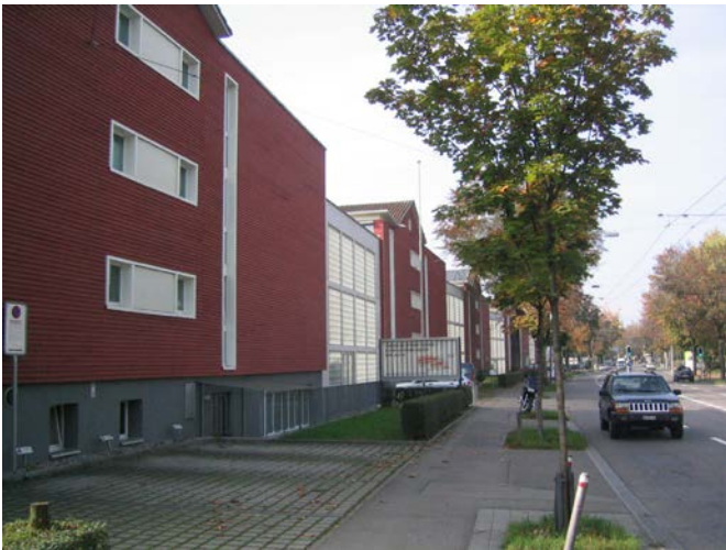
Die ursprünglich offenen Zeilenbauten quer zur Strasse erscheinen durch die gebäudehohen Abschlusswände zwischen den Bauten als geschlossene Überbauung.
