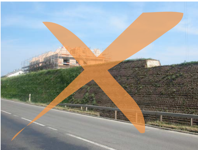
Unbefriedigende Einordnung: Übersteiler, unnatürlicher Erdwall mit Befestigung und wiesenartiger Begrünung.
