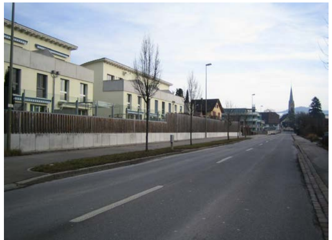
Auch mit einem breiten Rad-Gehbereich und einem Grünstreifen sowie einer Höhengliederung der Wand lässt sich die Siedlungsverträglichkeit nur selten verbessern.
