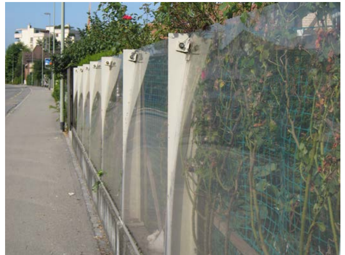
Geringfügig gewölbte Glaswand.
