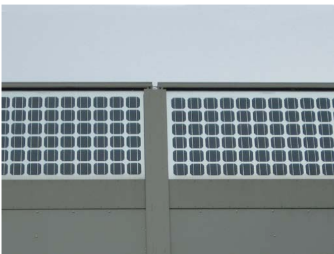
In Lärmschutzwände integrierte Fotovoltaik Elemente.
