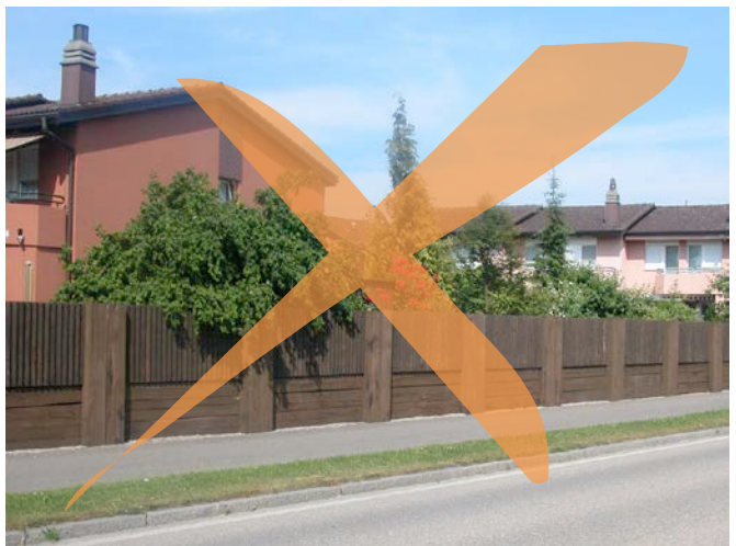
Unbefriedigende Einordnung: Klobige Holzkonstruktion in unterschiedlichen Verlegerichtungen.
