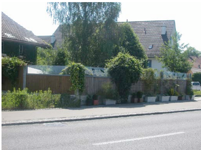
Die Lärmschutzwand schafft einen ortsuntypischen geschlossenen Aussenraum und der Wert des Ortsbildes wird entsprechend geschmälert.
