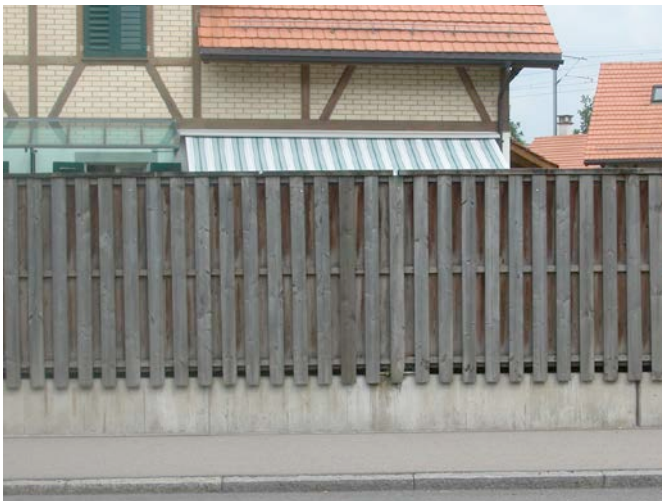
Holzwall mit vertikaler Lattung und unsichtbaren vertikalen Trägern.
