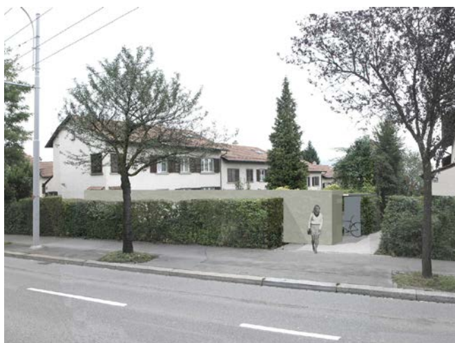
Durch eine Bepflanzung wird eine Lärmschutzwand weniger wahrgenommen, die Wirkung der Wand bleibt aber erhalten.
