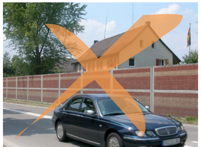
Unbefriedigende Einordnung: Einsatz von verschiedenfarbigen Backsteinen und markanter Tragkonstruktion.
