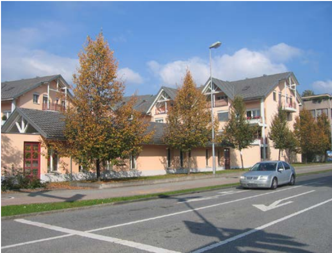
Gedeckte Aufenthaltshalle strassenseitig.
