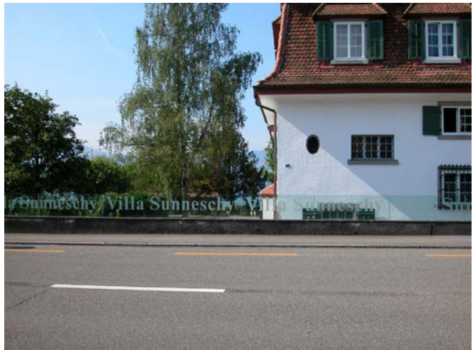
Die bestehende Sockelmauer wurde mit einer Glaswand subtil erhöht und schützt insbesondere den Aussenraum vor Lärm, ohne den Blick in den Garten zu verunmöglichen.
