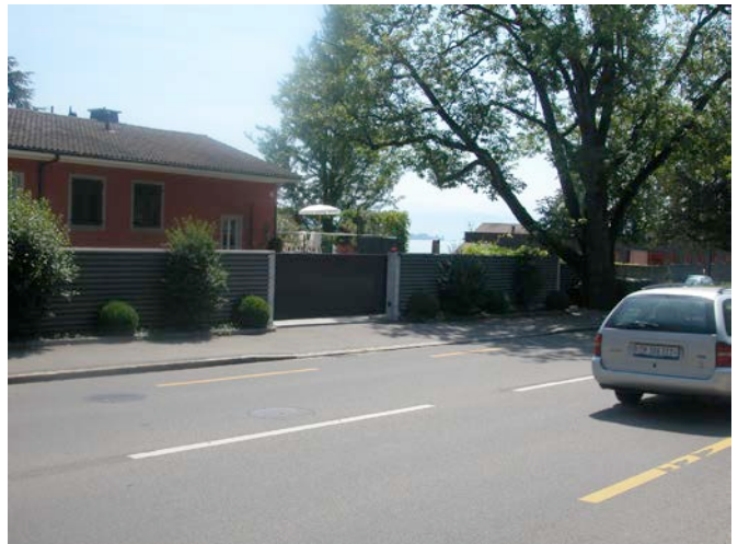
Wenn eine rückwärtige Erschliessung nicht möglich ist, kann durch ein integriertes Rolltor ein durchgehender Lärmschutz erzielt werden.
