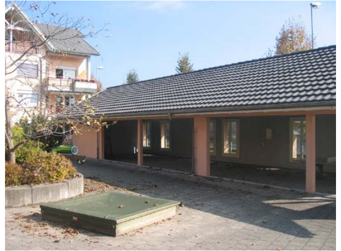
Gedeckte Aufenthaltshalle bebauungsseitig.
