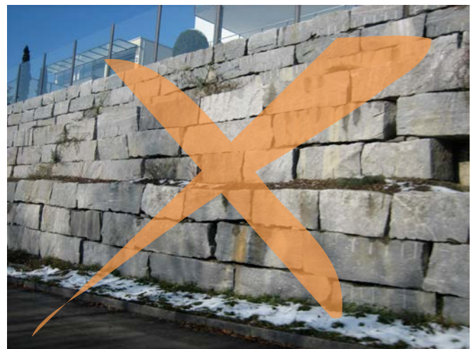
Unbefriedigende Einordnung: Grobe Verbauungssteine aus hellem Kalkstein.
