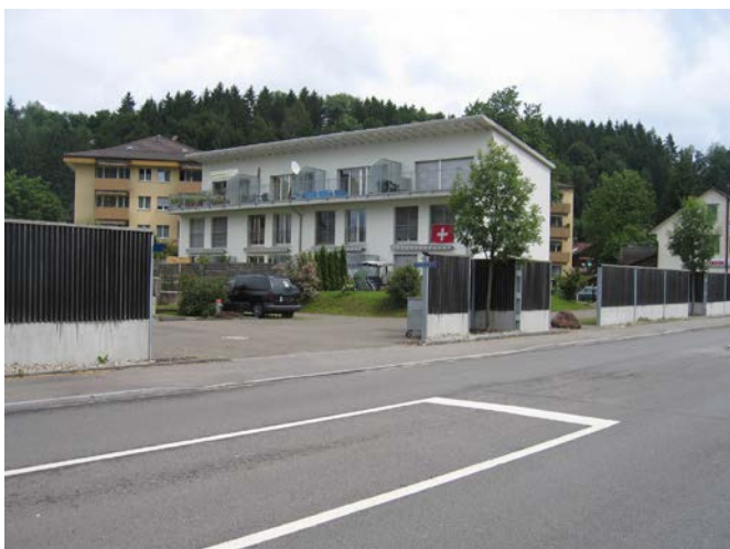
Aufgrund der Öffnungen in der Lärmschutzwand bei Zufahrten kann nur eine ungenügende Lärmschutzwirkung erreicht werden.
