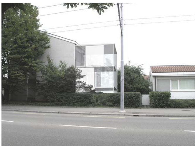
Anbauten bilden eine Abschirmung zur Strasse und schützen einen Teil des Aussenraums vor Lärm.
