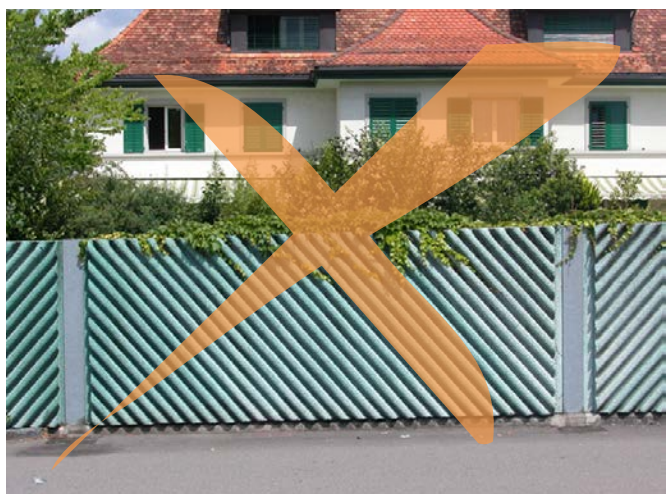
Unbefriedigende Einordnung: Grün eingefärbte Betonelemente mit Rippenstruktur.
