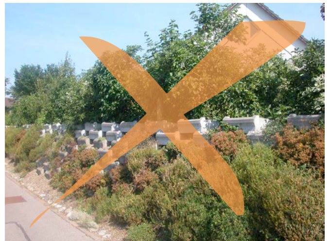
Unbefriedigende Einordnung: Kleinteilige Betonformsteine (Löffelsteine) mit inhomogenem Ausdruck (Beton, Erde, Bepflanzung).
