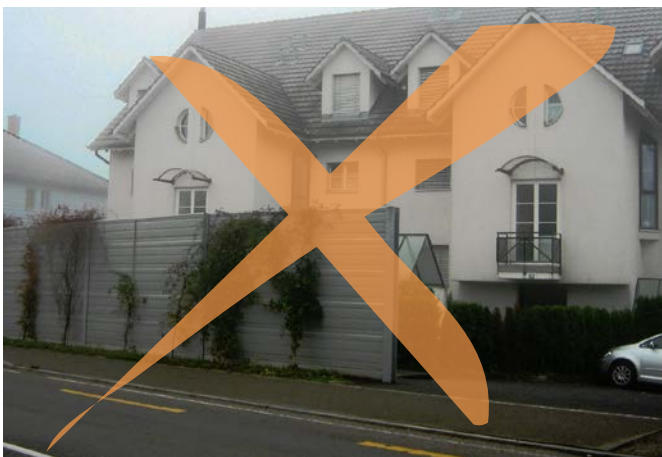
Unbefriedigende Einordnung: Übergangsloser Abschluss einer Stahlwand.
