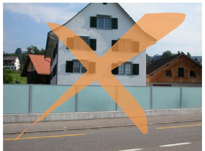
Unbefriedigende Einordnung: Milchglas bei Denkmalschutzobjekt.
