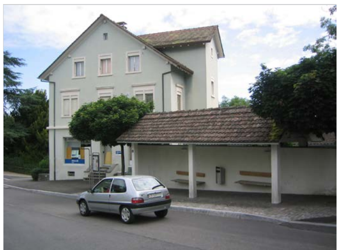
Mit einer in die Buswarte integriert Mauer wird das bestehende Ensemble ohne Beeinträchtigung der Schutzobjekte teilweise von Lärm abgeschirmt.
