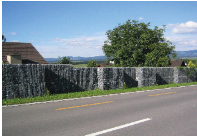
4 Längengliederung: Steinkorbwand mit Vor- und Rücksprüngen
