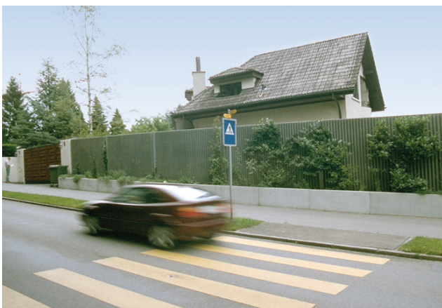
5 Gerippte Lavabeton-elemente, absorbierend, mit Kletterpflanzen begrünt.
