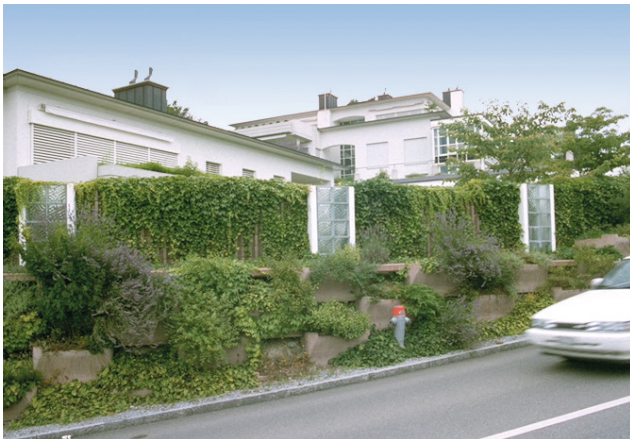
3 Strukturierte, absorbierende Betonwand mit Glasuren, begrünt.
