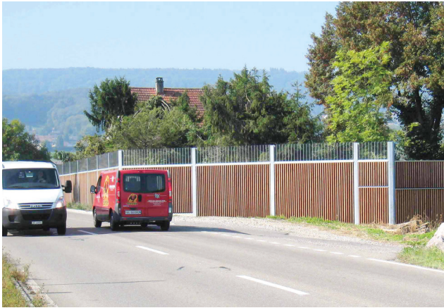
1 Lärmschutzwand aus Holz (Kiefer/Lärche) mit Glasoberteil, absorbierend.
