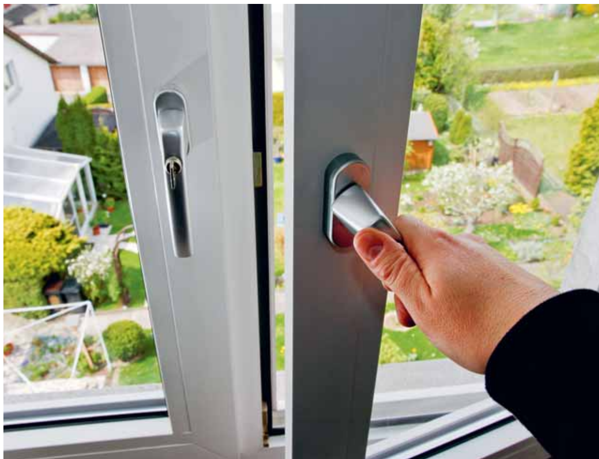
Das Lüftungsfenster garantiert eine angemessene Wohnqualität. Beträgt seine Fläche mindestens fünf Prozent der Bodenfläche, ist damit ein genügender Luftaustausch gewährleistet. Quelle: FALS
